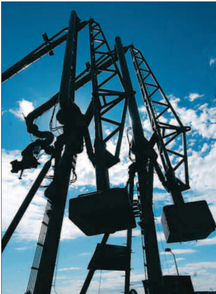
Pumparna kopplas till tankbåten från två stora kranar i oljehamnen.
