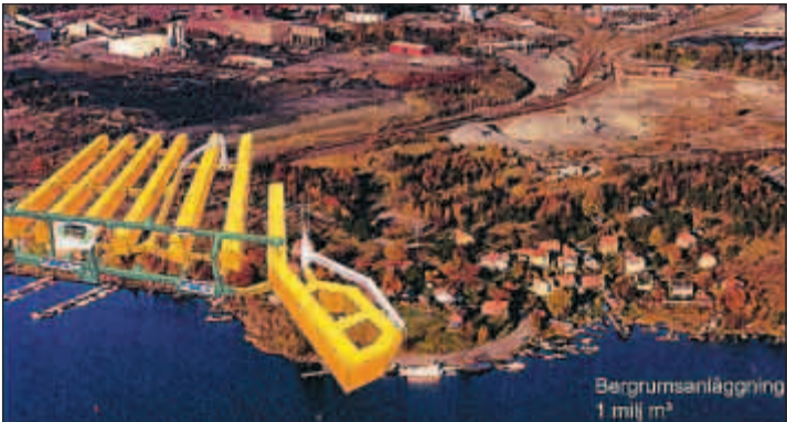
Sju berggrum finns under Gamla Oxelösund. Det största, som ligger närmast bygdegården, används inte i dag. De övriga sex är 250 meter långa, 25 meter breda och 25 meter höga. De förbinds av två gångar, en nere i djupet 40 meter under havsytan, och en ovanför berggrummens tak.
