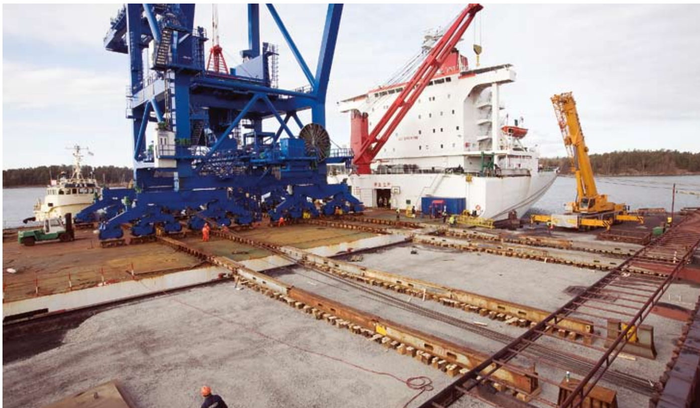
Allt är förberett för landning av kranen. Rälsssektioner är utlagda och vajerspelen är kopplade. Fartyget har anpassat höjden genom justering av ballast.
