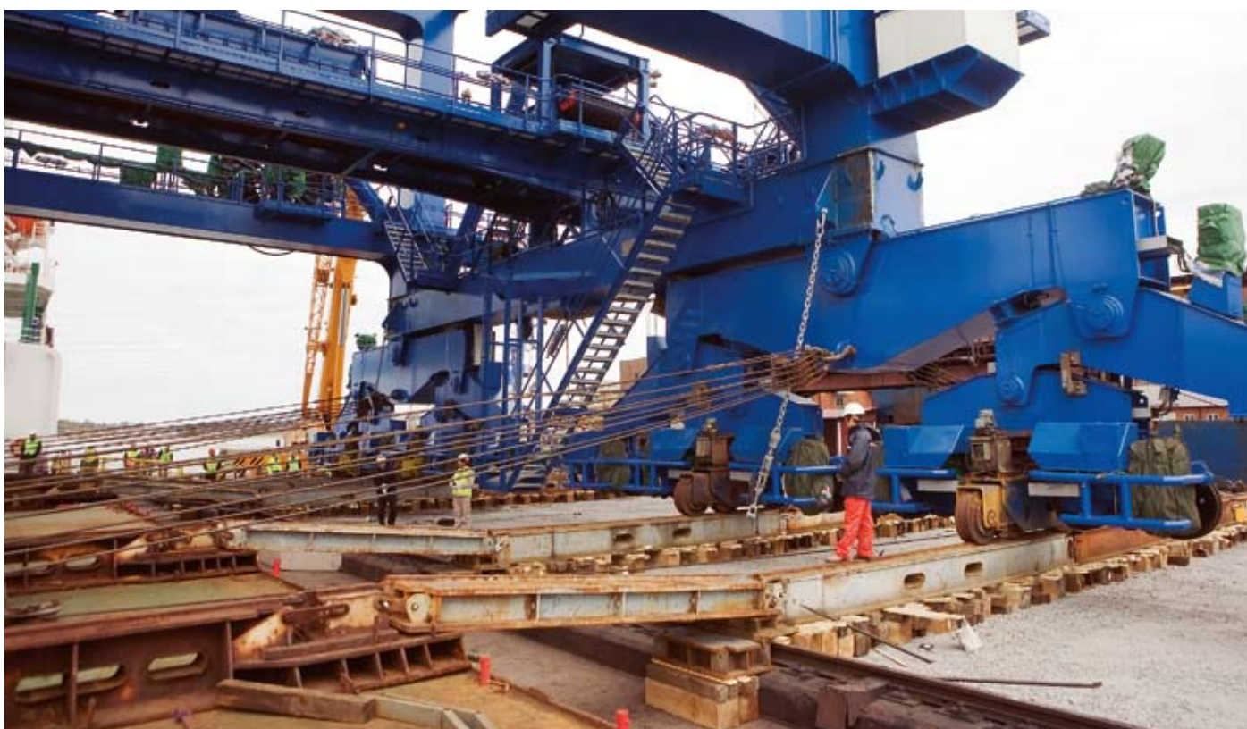
Nu börjar saker hända! Vajerspel drar på framsidan och håller emot på baksidan, så det gör inget att fartyget lutar lite.
