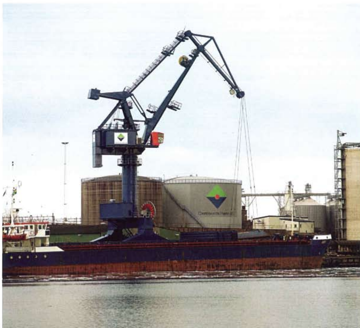
Bild 8. Ny kran i hamnen.
