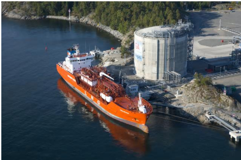
Figur 9. Exempel på atmosfärisk LNG-cistern i Nynäshamn (Linde).
